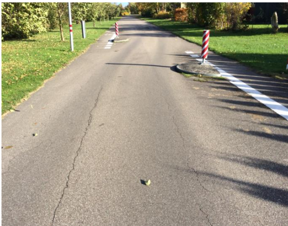
Foto 2. Ved Fuglevangens chikaner kanaliseres trafikken til ét snævert spor. Den gamle vejbelægning revner og krakelerer i køresporene, specielt i vejens yderside hvor flere parallelle revner forekommer.
