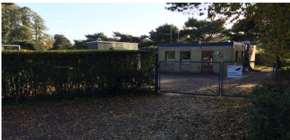
Foto 9: Rensningsanlægget for enden af Blåmejsevej.
