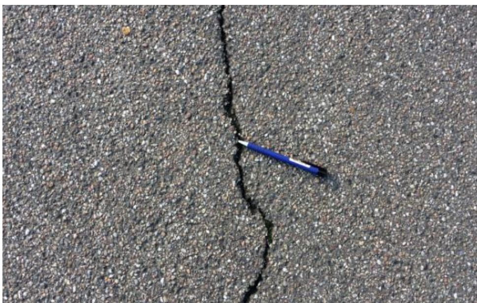
Foto 5: Nærbillede af revnen på ovenstående foto. Åbentstående revner giver anledning til vandnedsivning og efterfølgende intensiveret nedbrydning.
